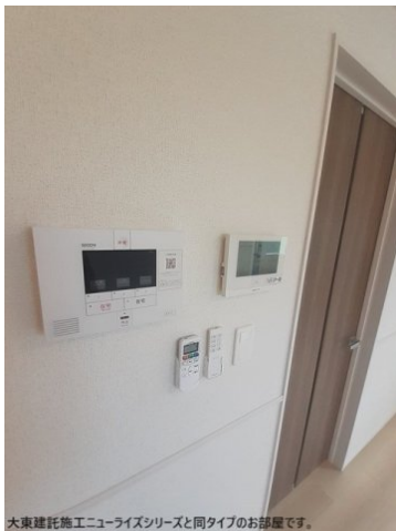
大東建託施工ニューライズシリーズと同タイプのお部屋です。
